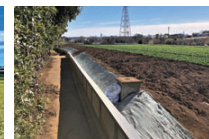
土砂流出防止対策/都筑区
