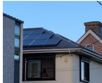
↑太陽光パネルの設置
